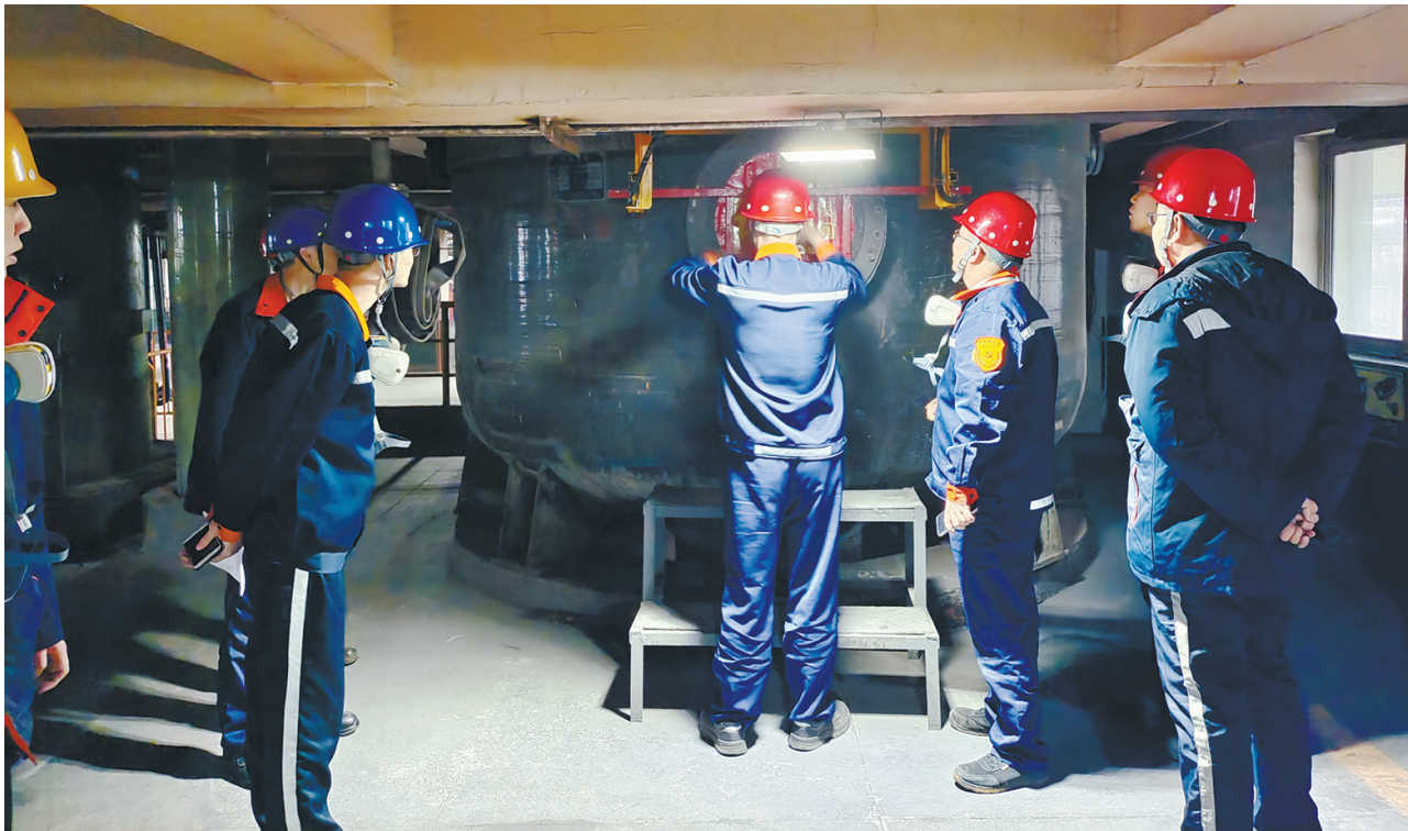
检修结束后认真复查,确保形成闭环管理,保证安全生产
